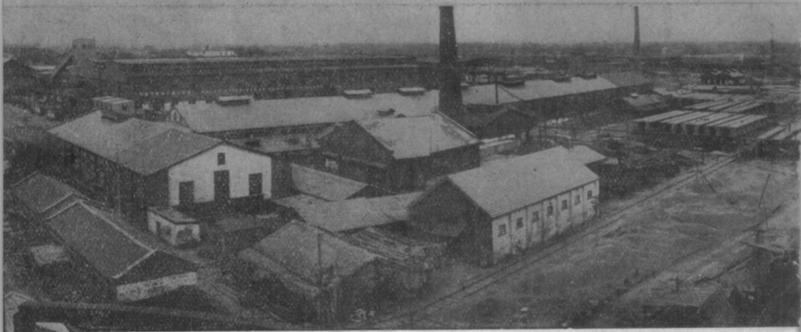
丰台桥梁工厂新建的厂房和工地。
